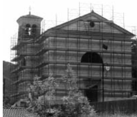
Lavori nella chiesa di Avasinis
