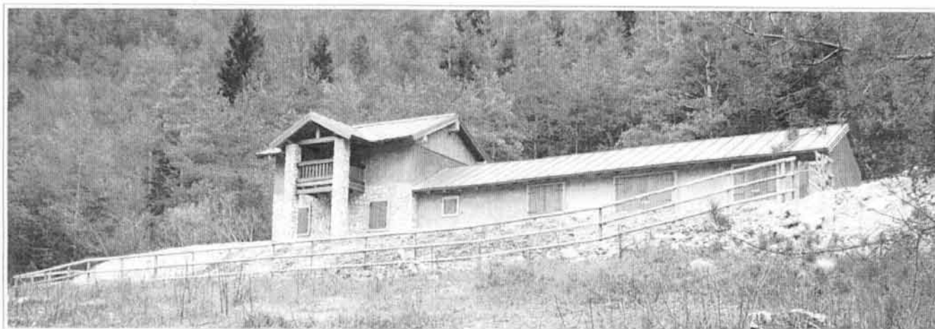
Malga Amula dopo i lavori di ristrutturazione.
